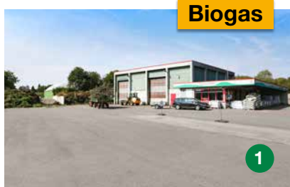
Kompostierungsanlage und Umladestation und Biogasanlage Enger
