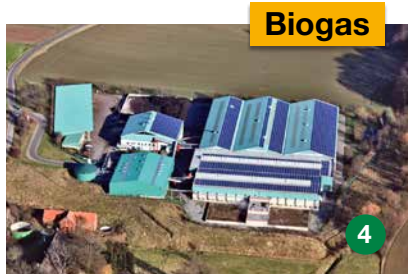
Kompostwerk und Biogasanlage Nieheim
