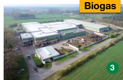
Kompostwerk und Biogasanlage Gütersloh
